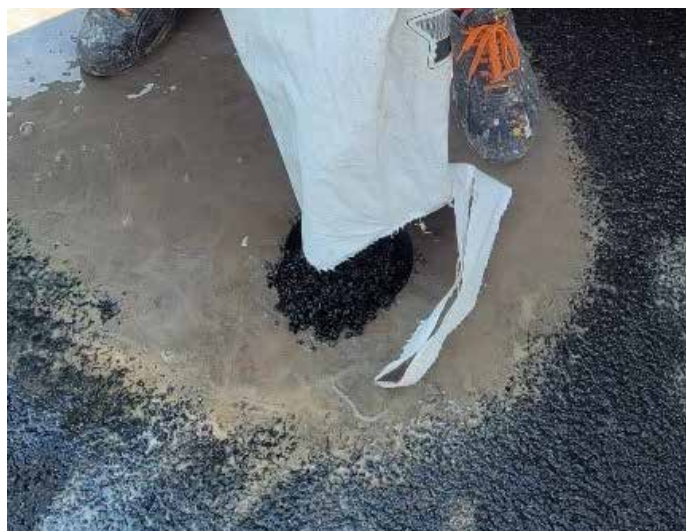
1. Chiusura di un carotaggio da pavimentazione stradale con asfalto a freddo
