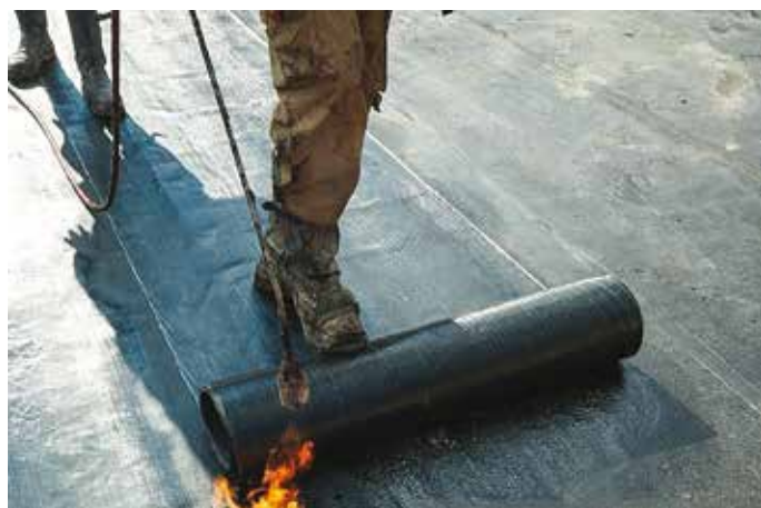
1. Applicazione di una membrana bituminosa
