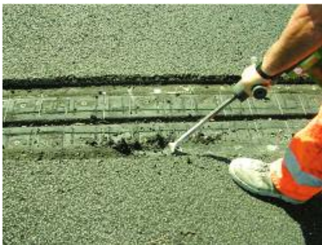
FIG. 6a Demolizione conglomerato posato sul giunto
