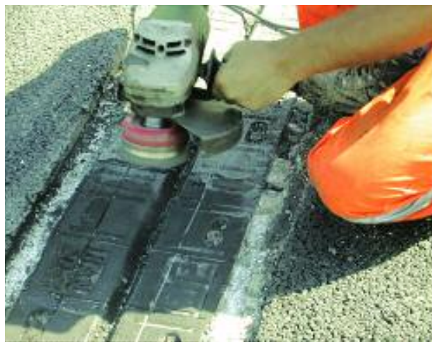
FIG. 6b Irruvimento della superficie del giunto
