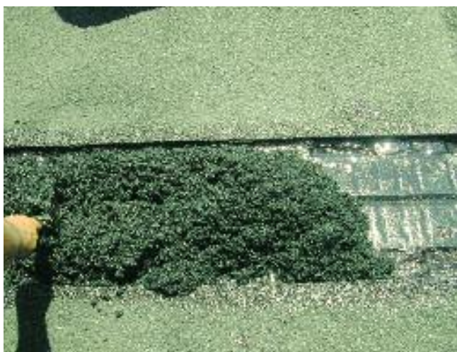
FIG. 6c Posa della cappa insonorizzante
